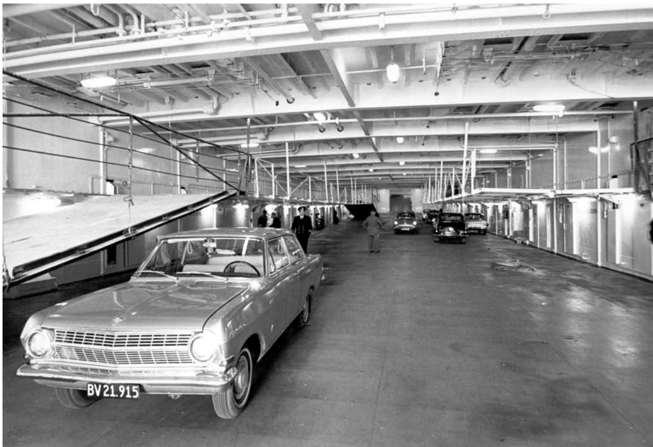
Det rummelige vogndæk på "Grenaa" som det tog sig ud ved leveringen. Ved at anvende hængedæk med to rækker vognbaner, nåede kapaciteten op på imponerende 180 personbiler. . (Foto Søren Thorsøes arkiv).
